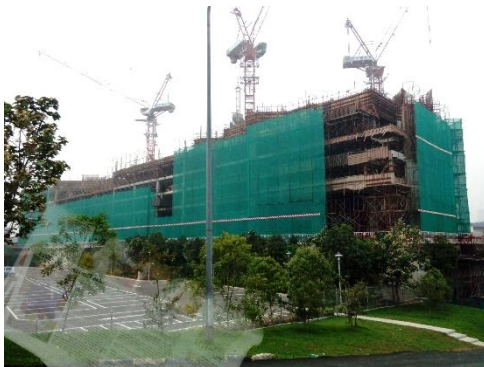
●Astaka: 6階部分枠組み完成
