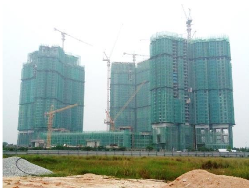
●Teega: 壁・ドア・窓枠設置工事中
