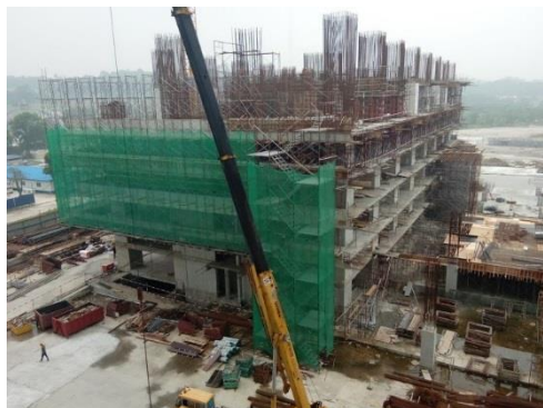
●Bora: 6階部分枠組み工事中
