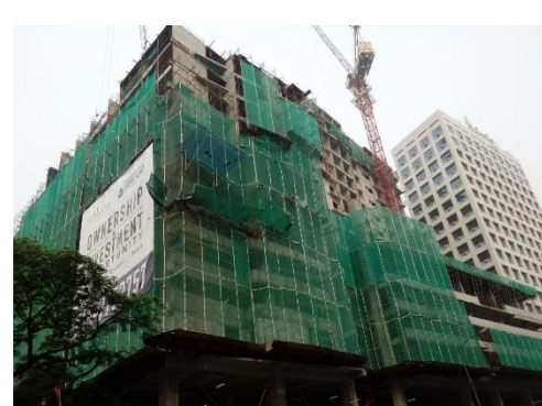
●Suasana: 18階枠組み工事中
