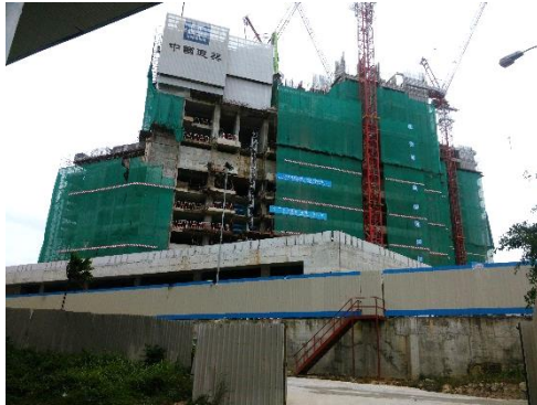
● Astaka: 12階部分枠組み工事中
